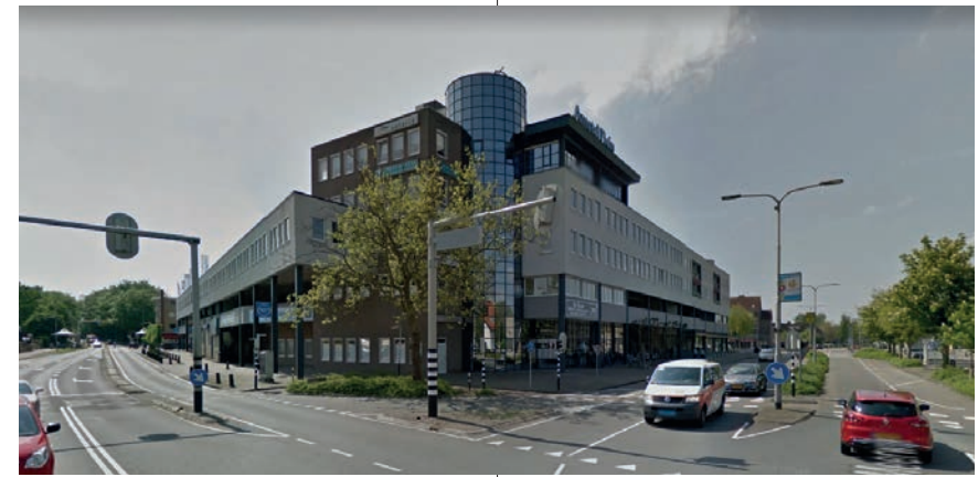
Oude situatie kantoorraanzicht
